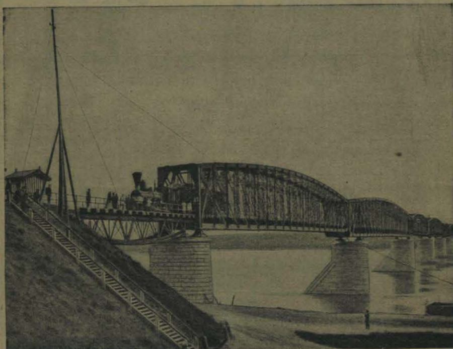
PUENTE DEL TRANSIBERIANO SOBRE EL OB'
