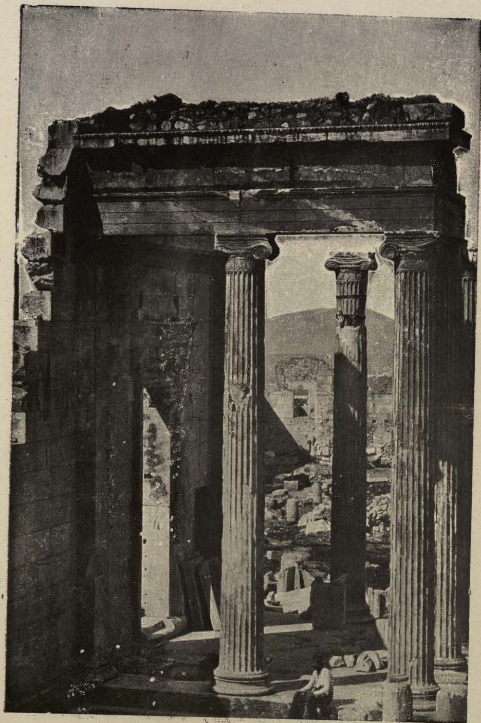
COLUMNAS JÓNICAS DE LA ERECHTEA EN ATENAS FIN DEL SIGLO V ANTES DE LA ERA VULGAR
