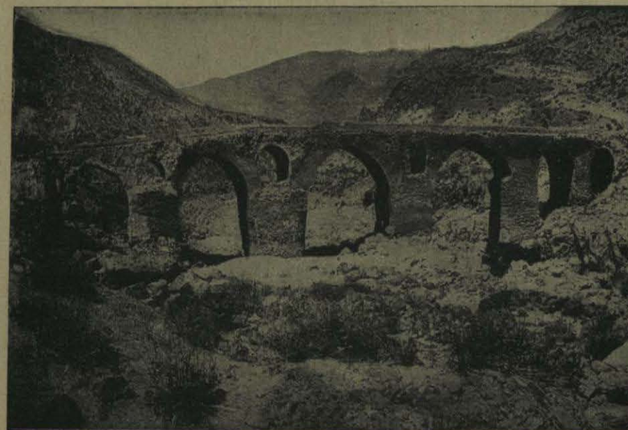
PUENTE DE LEIS SOBRE EL KIZIL-UZEN (GHILAN)
