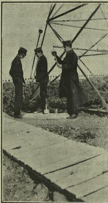
OBSERVATORIO DE AÑO NUEVO (Termómetro de profundidad, con el que se aprecia la temperatura interior de la tierra).
