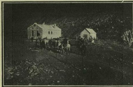
PUENTE DEL INCA. LA CASA DE LOS CORREOS
