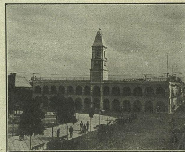
ANTIGUO CABILDO DE TUCUMÁN (Demolido recientemente).
