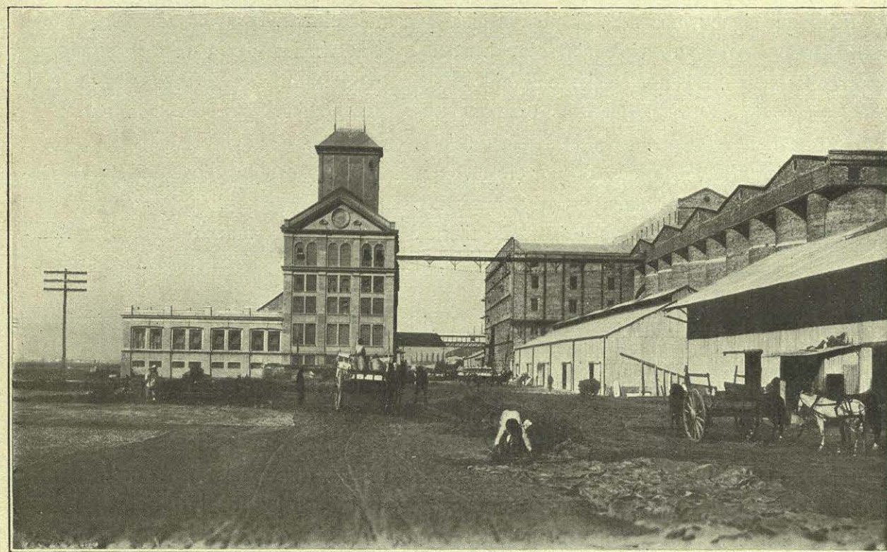
BUENOS AIRES: ELEVADORES DE TRIGO EN PUERTO MADERO
