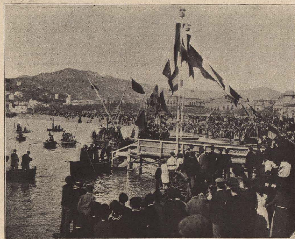
S. FELIU DE GUIXOLS — COLOCACION DE LA PRIMERA PIEDRA Fotografías de Jesús Giral.
