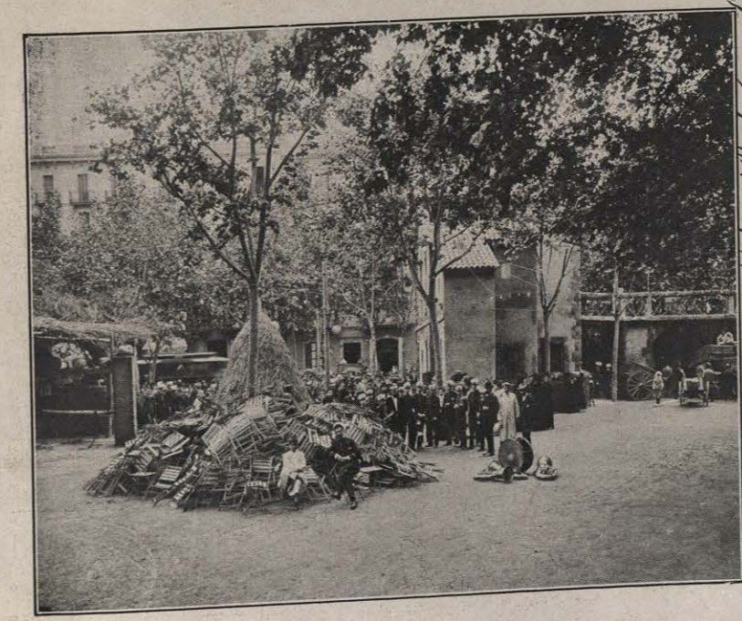
CALLE DE CONDAL. — CALLE DEL CARMEN. — MASÍA-CATALANA EN LA PLAZA DE SEPÚVEDA (Patio). — PUERTAFERRISA.
