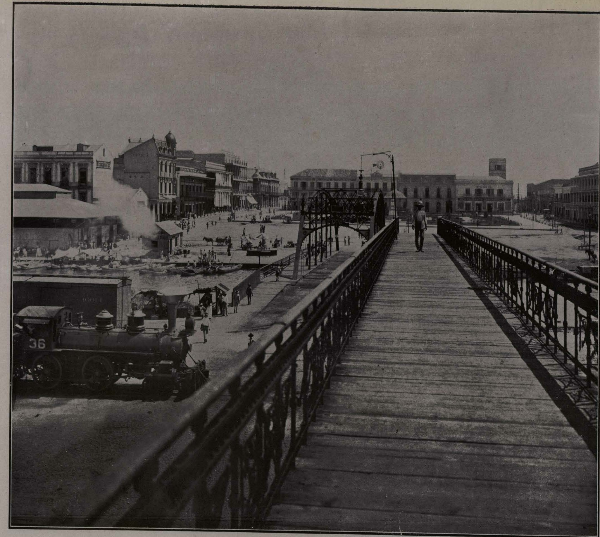
VIADUCTO DE LA ADUANA, TAMPICO, TAMAULIPAS.
