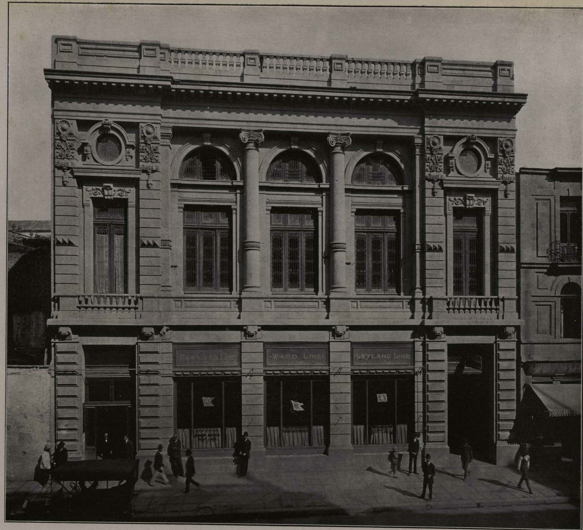
EDIFICIO DE LAS LÍNEAS DE VAPORES. MÉXICO.
