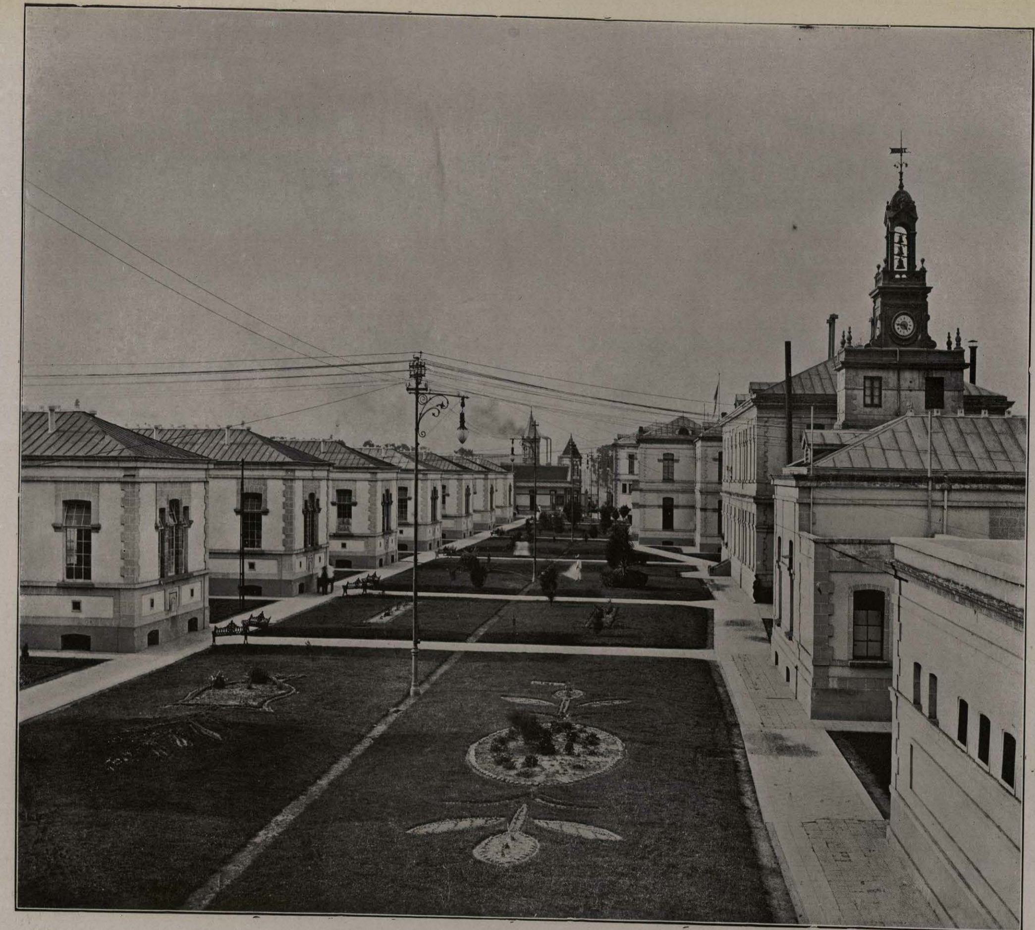
HOSPITAL GENERAL DE MÉXICO. (Pabellones).
