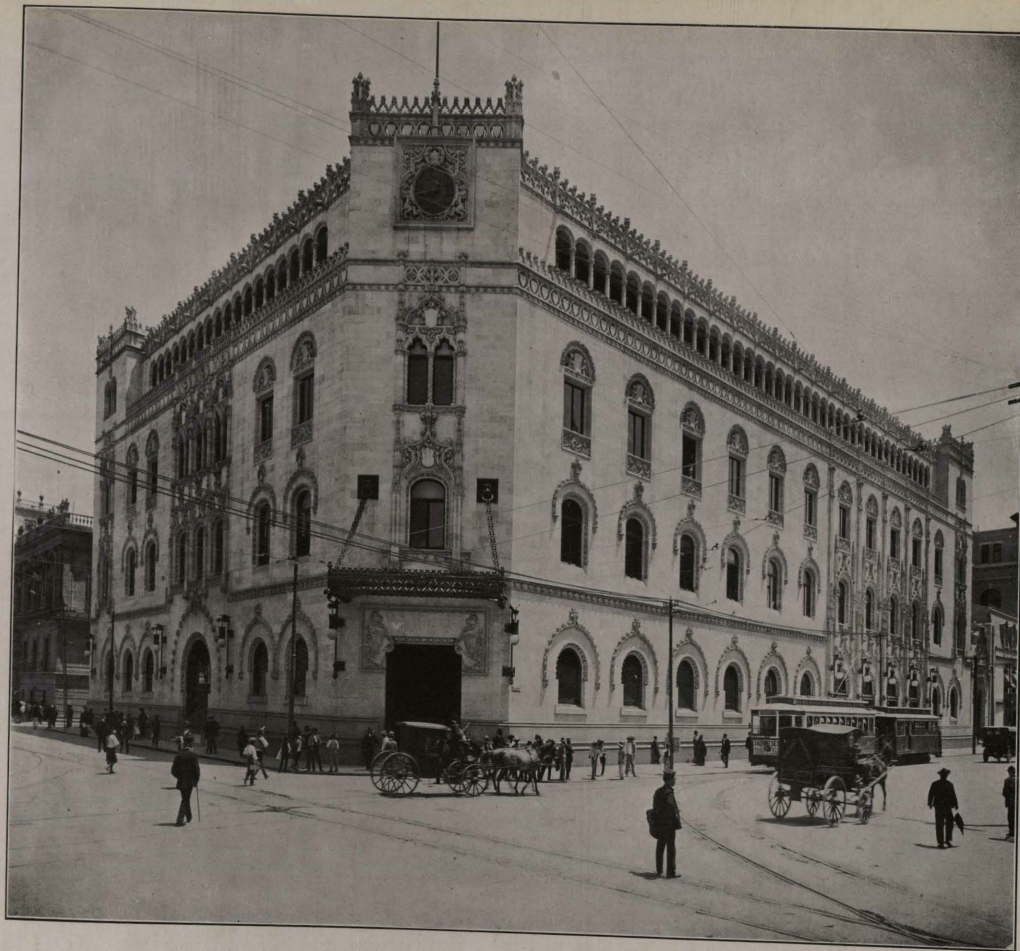
EDIFICIO DE CORREOS, MÉXICO.
