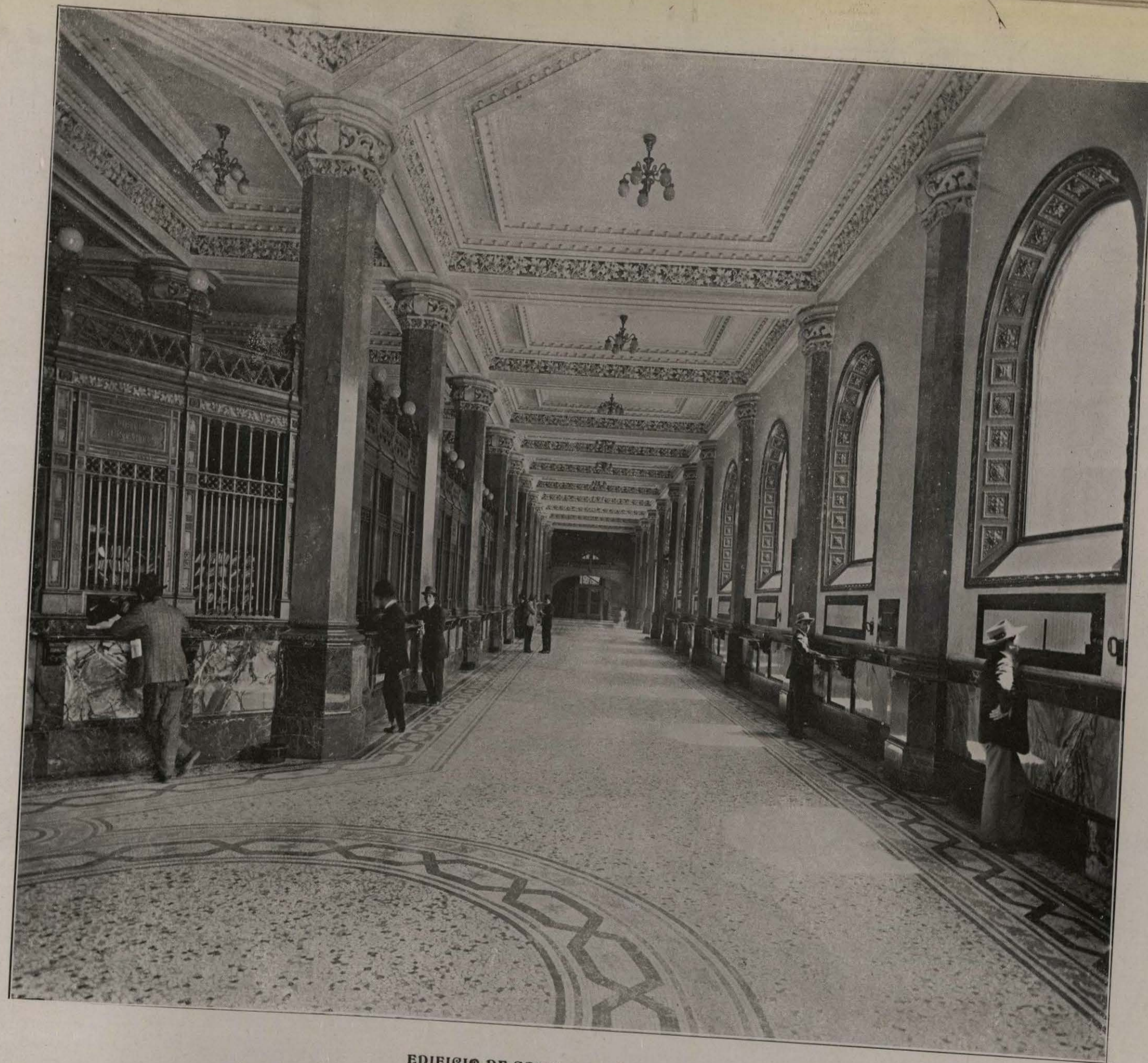
EDIFICIO DE CORREOS, MÉXICO.
