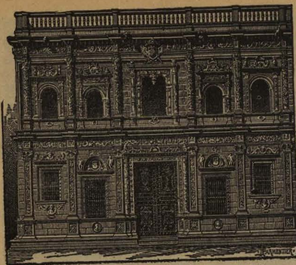
Fachada del Ayuntamiento de Sevilla (siglo XVI)
