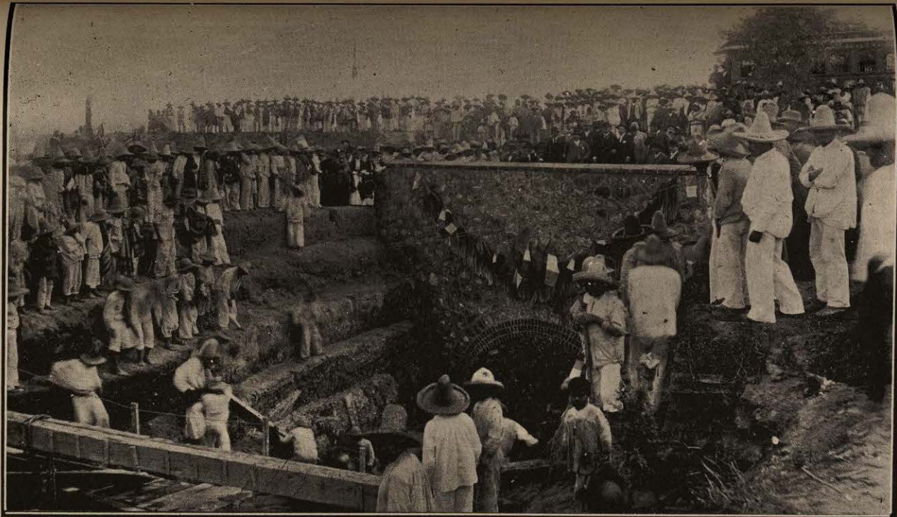
EL TUNEL DE DESAGÜE
