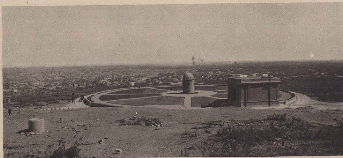
28. — OBRAS DE PROVISIÓN DE AGUAS DE MONTERREY. — DEPÓSITO DEL SUR
