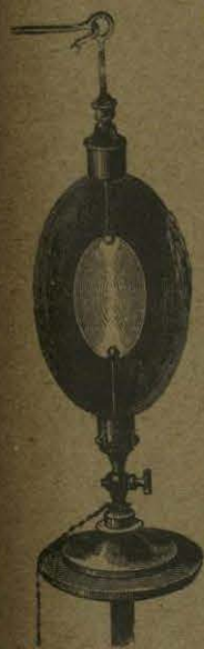
Fig. 333. El huevo eléctrico.
