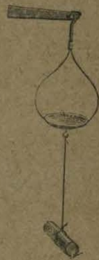
Fig. 70. Se pesa el cuerpo en el aire
