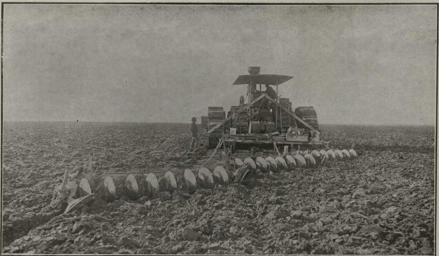
Fig. 13.—Arado poldisco tirado por máquina de vapor
