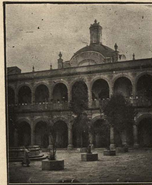
PATIO PRINCIPAL Y CÚPULA DE LA GRAN ESCALERA DEL COLEGIO DE SAN IGNACIO «Las Vizcainas.»
