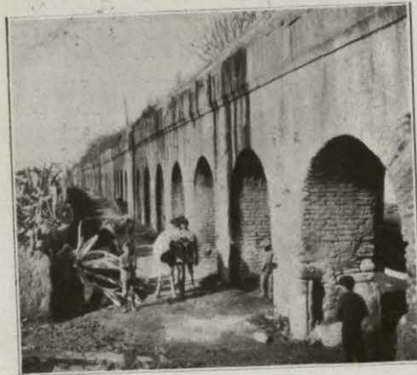
Fig. 729. — Los caños de Carmona. SEVILLA.
