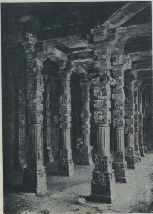
Fig. 227. — Siringam. Construcción de piedra imitando un techo de madera.
