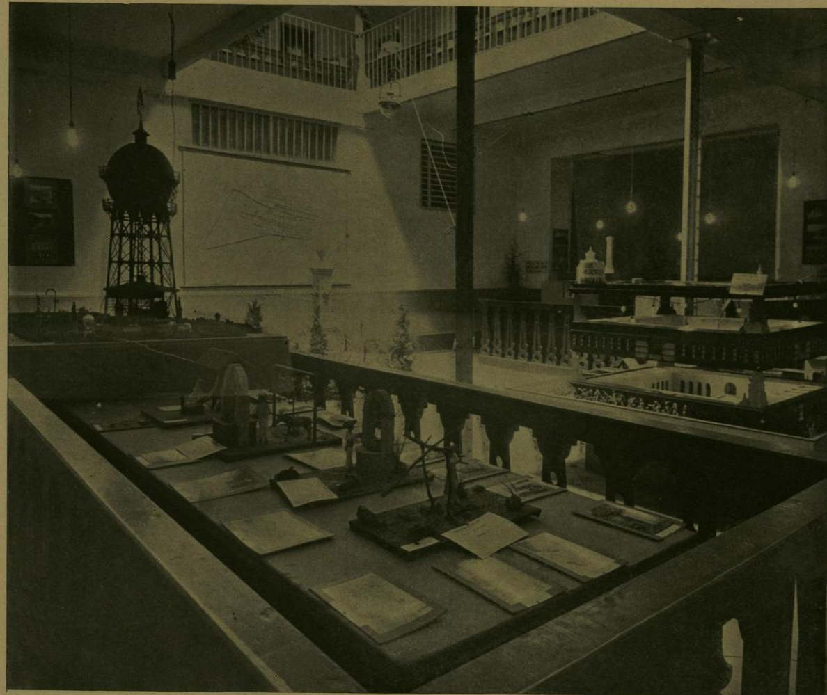
SISTEMAS DE APROVISIONAMIENTO DE AGUAS POTABLES EN LA EXPOSICION DE HIGIENE.
