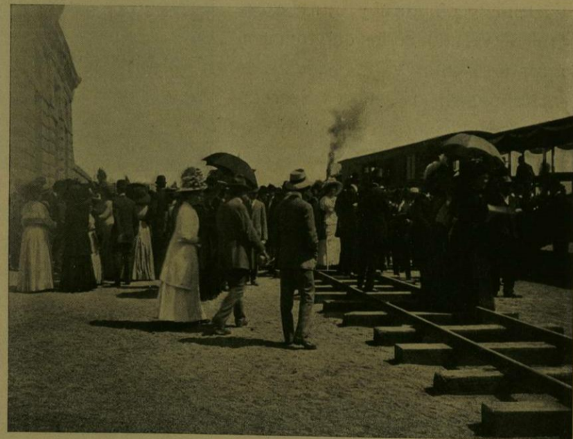
ASPECTO DE UNA ESTACION DE LAS OBRAS DE AGUAS POTABLES.
