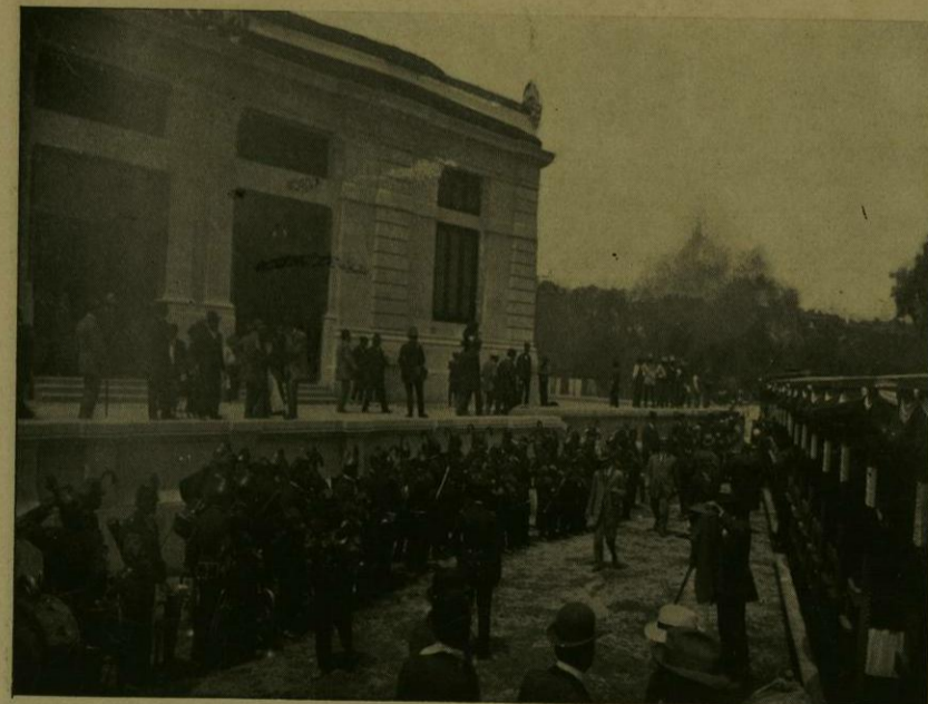
EL EDIFICIO DE LAS BOMBAS DE AGUAS POTABLES.
