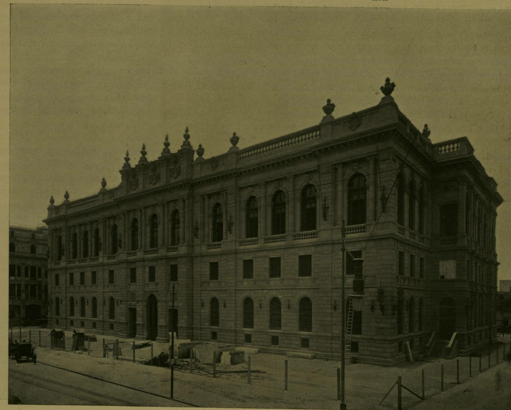
SECRETARIA DE COMUNICACIONES Y OBRAS PUBLICAS (EN CONSTRUCCION).
