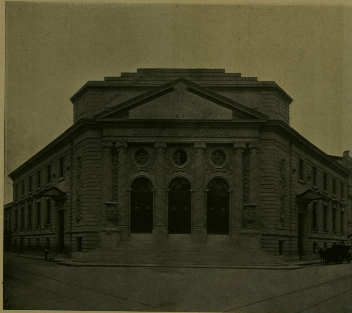
CAMARA DE DIPUTADOS (EN CONSTRUCCION).
