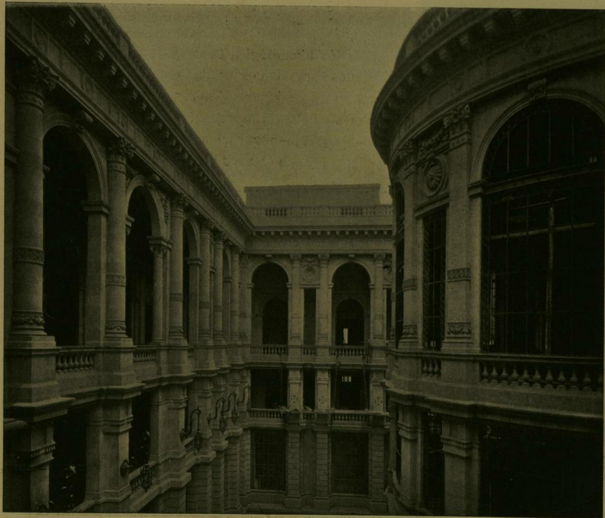
PATIO LATERAL DE LA SECRETARIA DE COMUNICACIONES Y OBRAS PUBLICAS (EN CONSTRUCCION).
