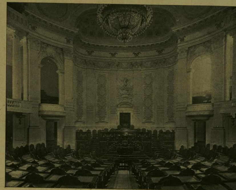
SALA DE SESIONES DE LA CÁMARA DE DIPUTADOS (EN CONSTRUCCION).
