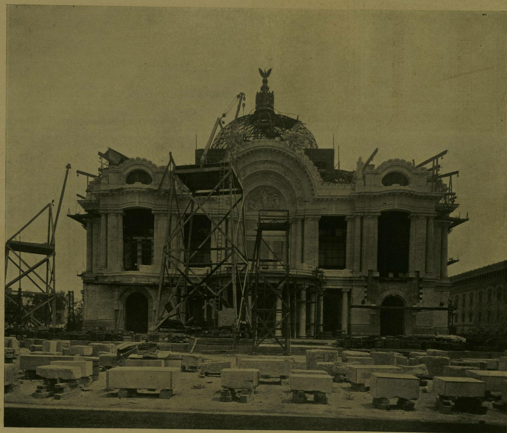
FACHADA PRINCIPAL DEL TEATRO NACIONAL (EN CONSTRUCCION).
