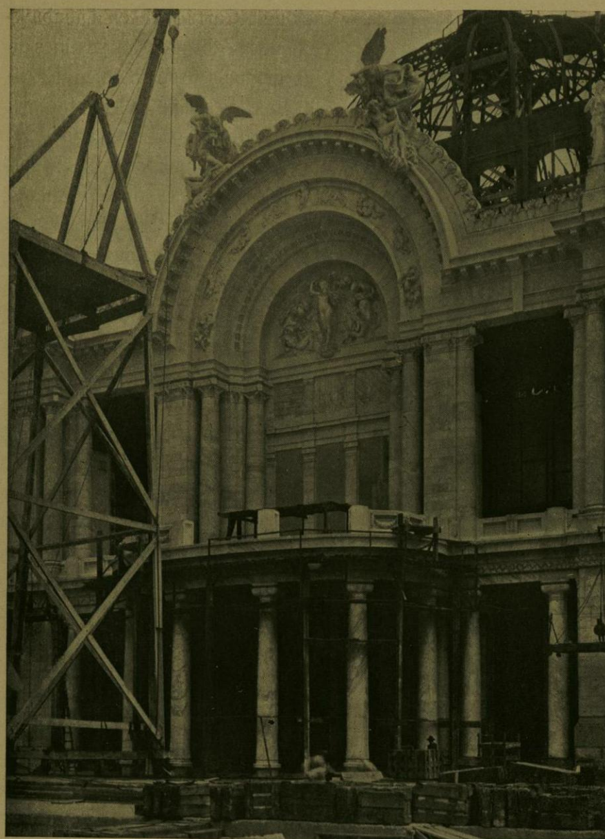
ENTRADA PRINCIPAL DEL TEATRO NACIONAL (EN CONSTRUCCION).
