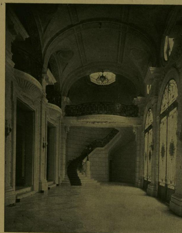
VESTIBULO DE LA CÁMARA DE DIPUTADOS (EN CONSTRUCCION).
