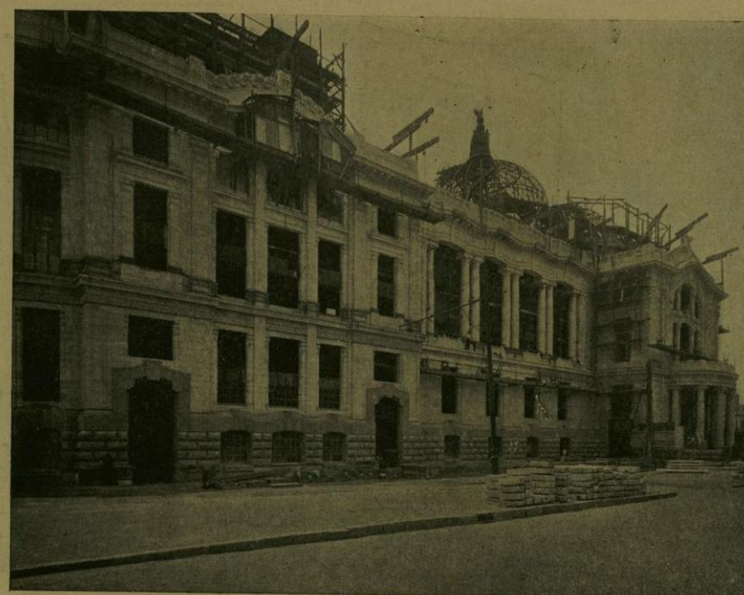
FACHADA LATERAL DERECHA DEL TEATRO NACIONAL (EN CONSTRUCCION).
