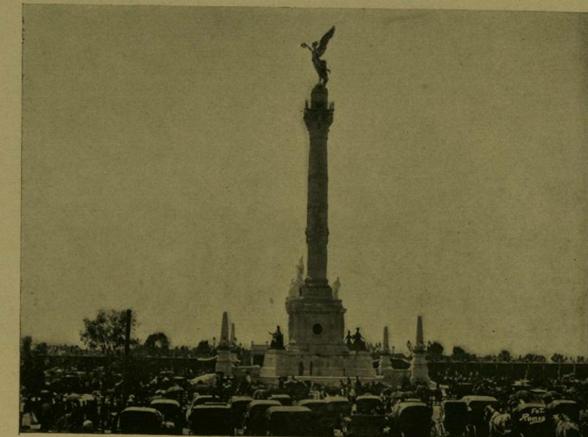
LA GLORIETA DE LA COLUMNA DE LA INDEPENDENCIA, EL DIA DE LA INAUGURACION DE ESTA.
