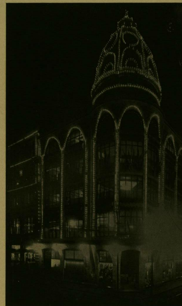
EL EDIFICIO DE «LAS FABRICAS UNIVERSALES» ILUMINADO.
