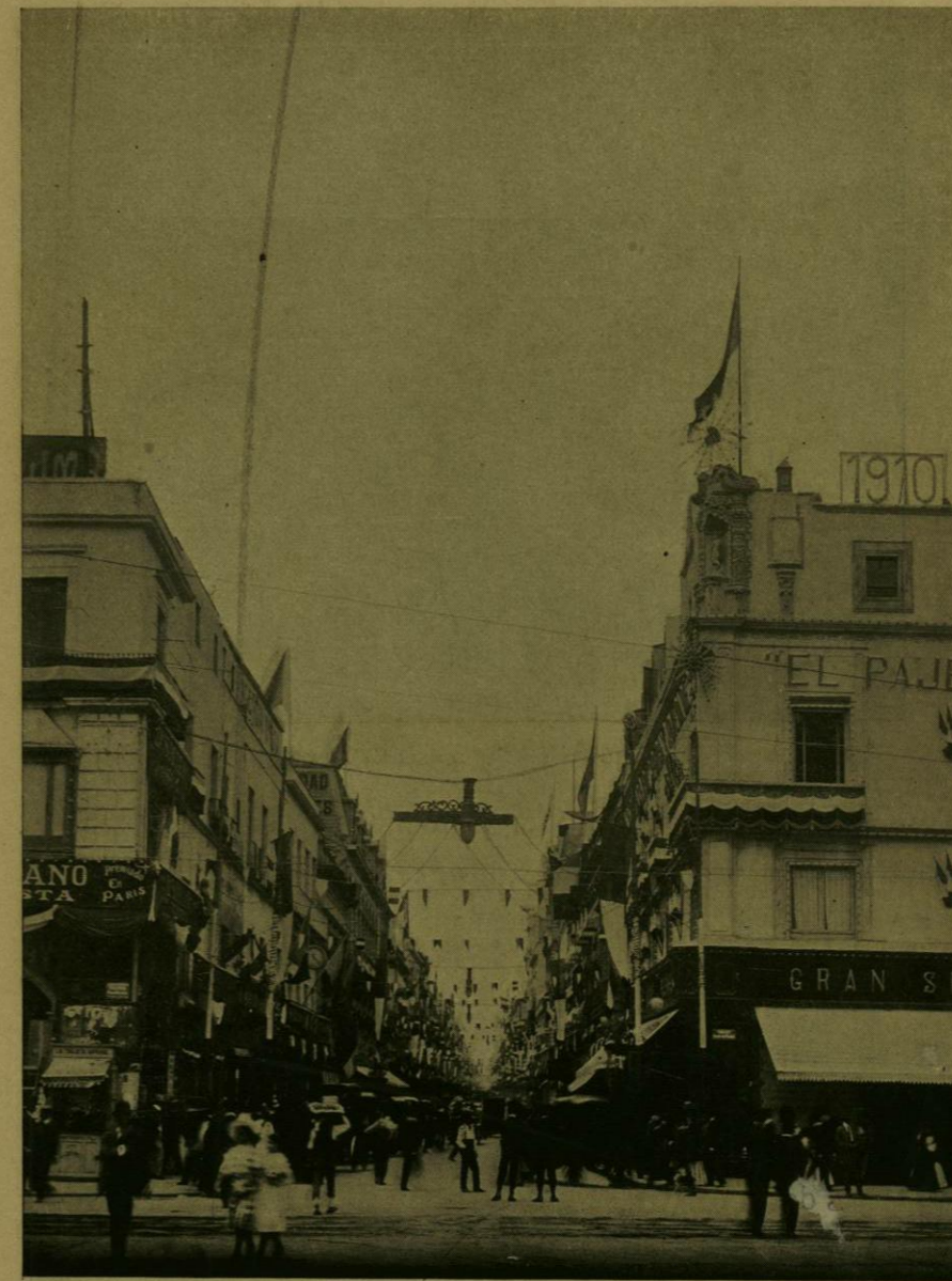
AVENIDA DE SAN FRANCISCO (ORIENTE A PONIENTE).
