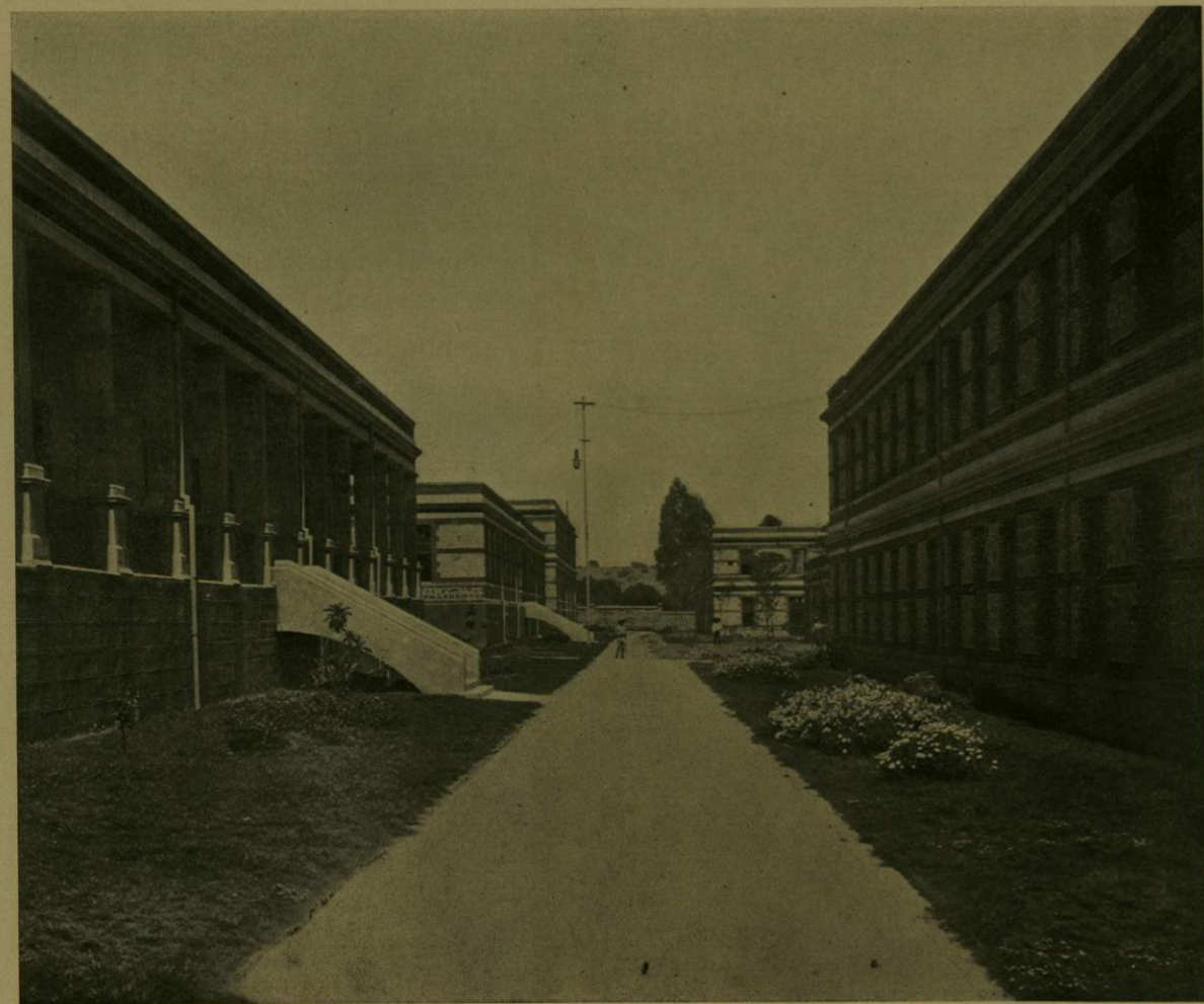
CALLE INTERIOR (NORTE A SUR) DEL MANICOMIO GENERAL.
