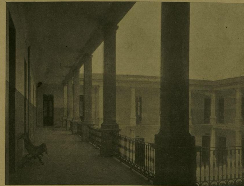
CORREDOR DEL PATIO PRINCIPAL DEL EDIFICIO DE SERVICIOS GENERALES EN EL MANICOMIO GENERAL.
