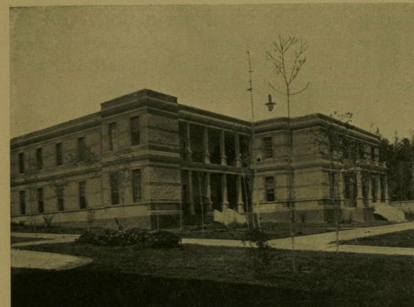
EDIFICIO PARA ALCOHOLICOS EN EL MANICOMIO GENERAL.
