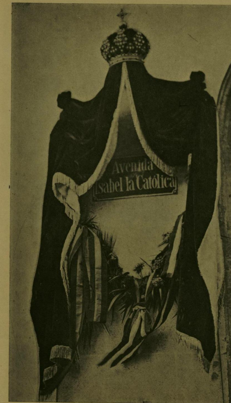
LA PRIMERA PLACA DESCUBIERTA EN LA AVENIDA ISABEL LA CATOLICA.
