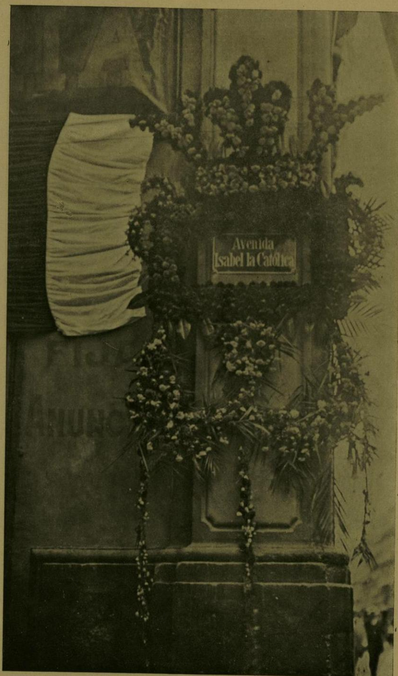
LA SEGUNDA PLACA DESCUBIERTA EN LA AVENIDA ISABEL LA CATOLICA.
