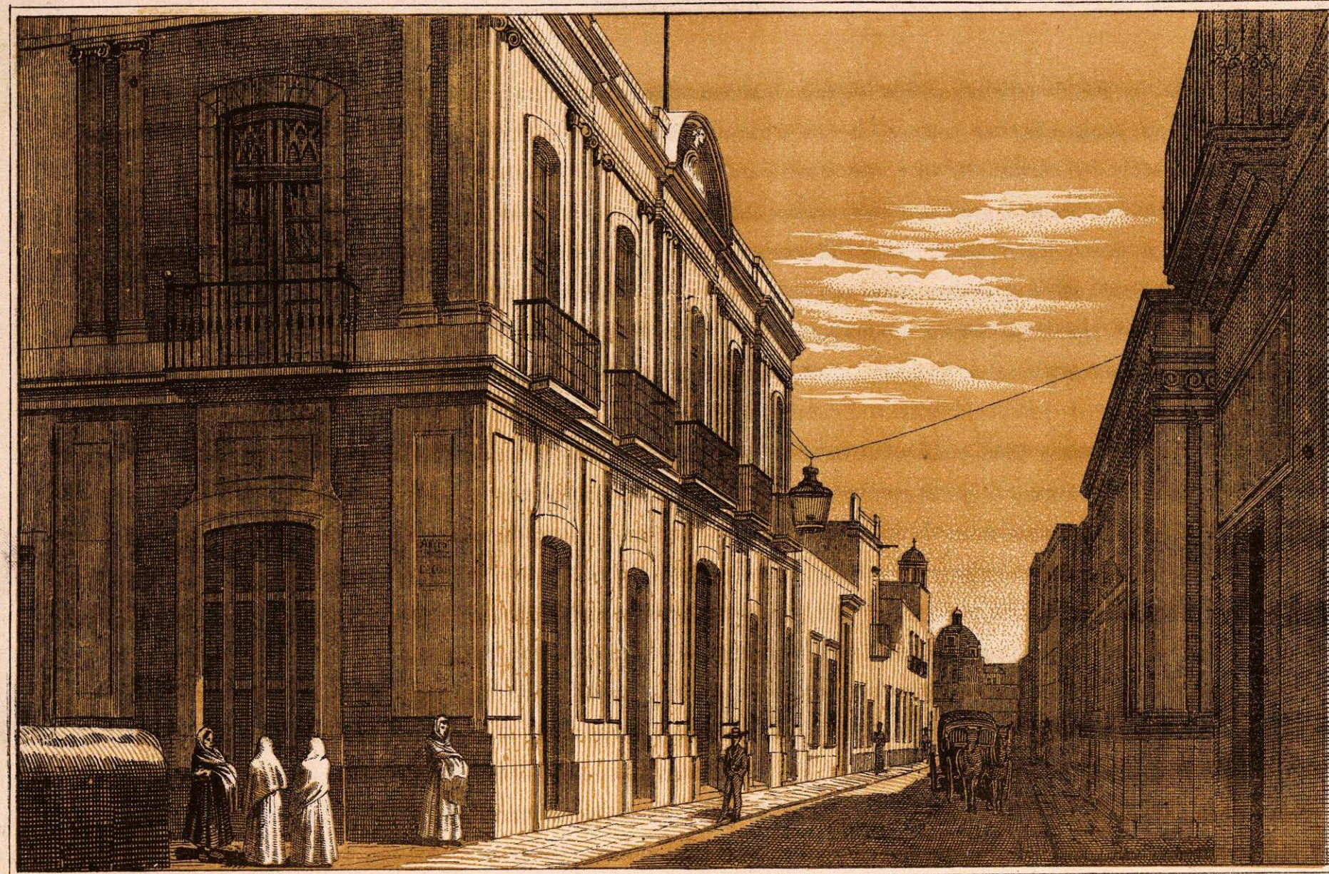
EDIFICIO DESTINADO A LA EXPOSICION.
