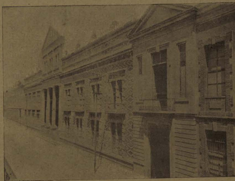
Fachada nueva del Hospicio.
