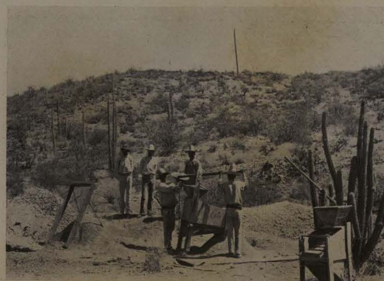
CALAMAHI En los placeres de oro de Calamahi: lavado de las arenas auríferas por el viento por medio de máquinas soplantes.
