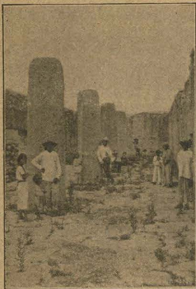
Columnas monolíticas de Mitla.
