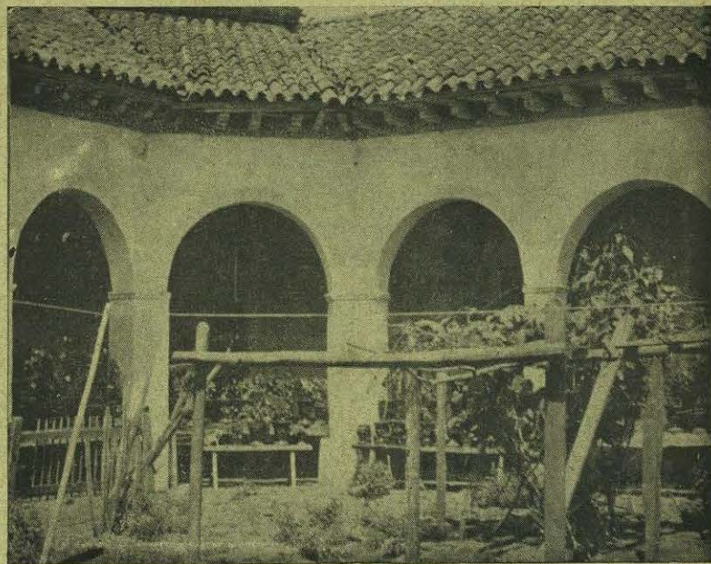
Colegio de S. Nicolás en Pátzcuaro. ( Interior. ) Estado actual.
